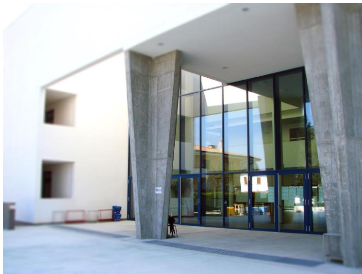
Edificio di via Sansovino, 6/a: l'ingresso nord
